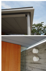
深い軒のあるポーチ
