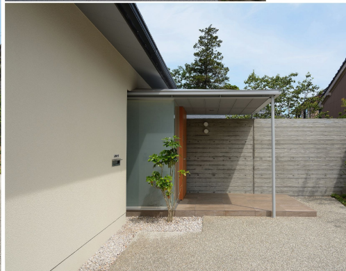
家の前に植樹 打ち抜くコンクリートの壁が暖色の光景を透射する
