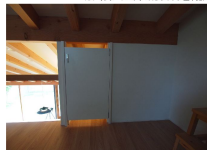
RA（リターンエア）のためのドア上下開口
