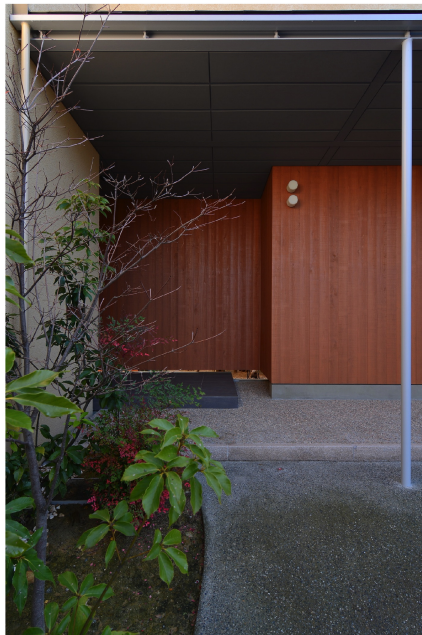
板壁の下に中庭とつながる開口（風通し）が見える
