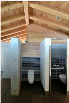
幼児用便器と三角形の耐力壁面 (ここで屋根構造を戻めている)
