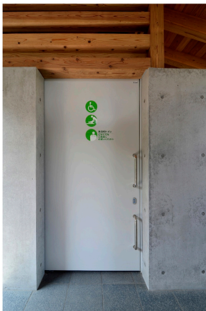
多目的トイレ入口
